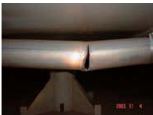
図2 折損したフロートチューブ
